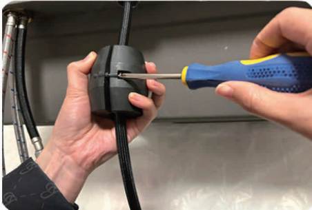
4. Установите крепеж для выдвижного смесителя (длина установки не должна превышать длину гибкого шланга смесителя с этой стороны).
