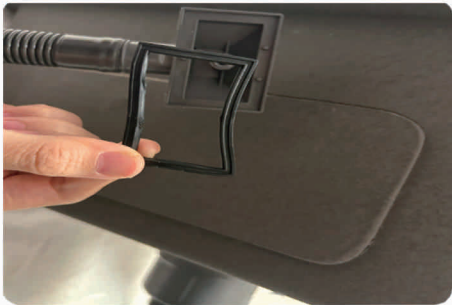
10. Нанесите силиконовое уплотнительное кольцо на край переливного отверстия (можно также нанести герметик).
